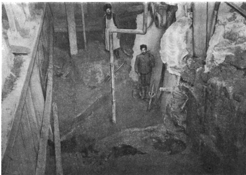
Ремонт каптажа Нарзана в Кисловодске.
